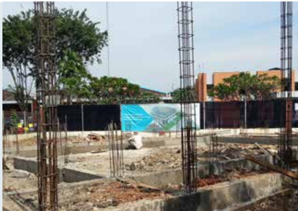
Pembangunan Musholla At-Taqwa Garuda Cargo
